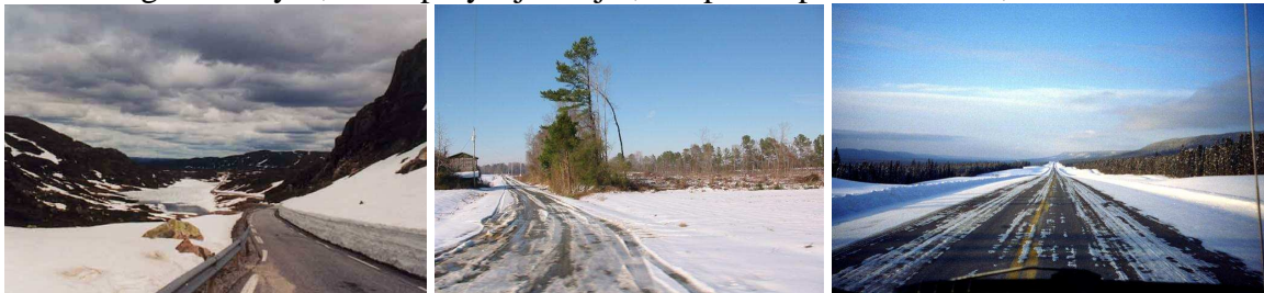
Rys. 3. Przykłady złego projektowania niwelety
